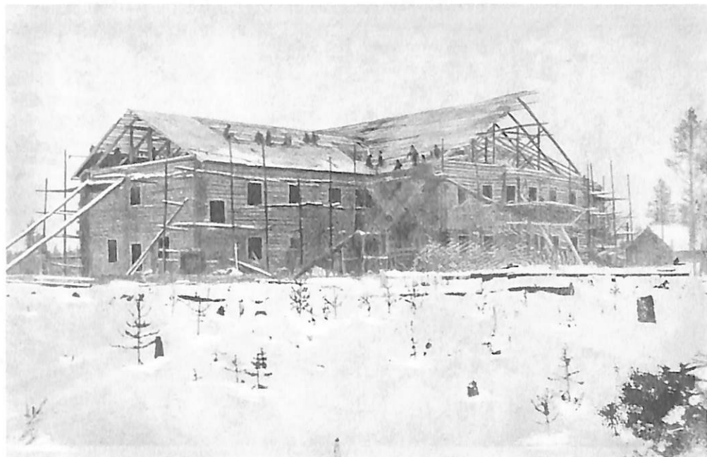
Строительство химзавода № 1, 1931 г. (из архива И.В. Дахно)
